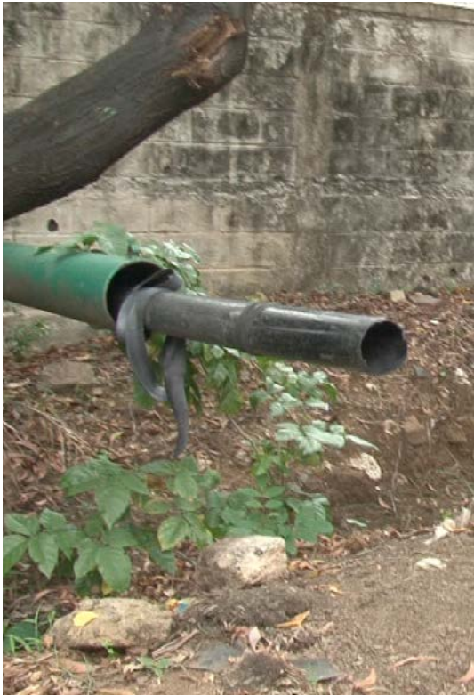
Abwasserrohr, das direkt aus der Wand der Orchid Pharma Antibiotikafabrik in Alathur kommt, nahe Chennai. Orchid behauptet, dass dieser Produktionsort über eine 'Zero Liquid Discharge' Abwassertechnologie verfügt
