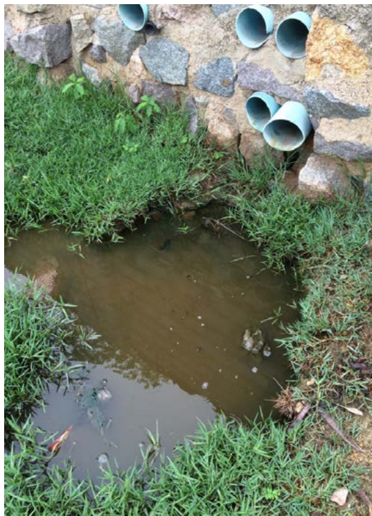
Pfützen mit grünem stehendem Wasser außerhalb der Umzäunung der Ramky Giftmüllanlage, Guddapatharm Industrial Area, Hyderabad.
