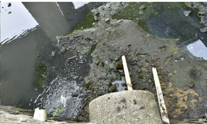
Zwei Ausläufe (einer groß, einer klein) aus den Wänden der Zhuhai United Laboratories. Sie leiten Abwasswer direkt in den Nanpai River
