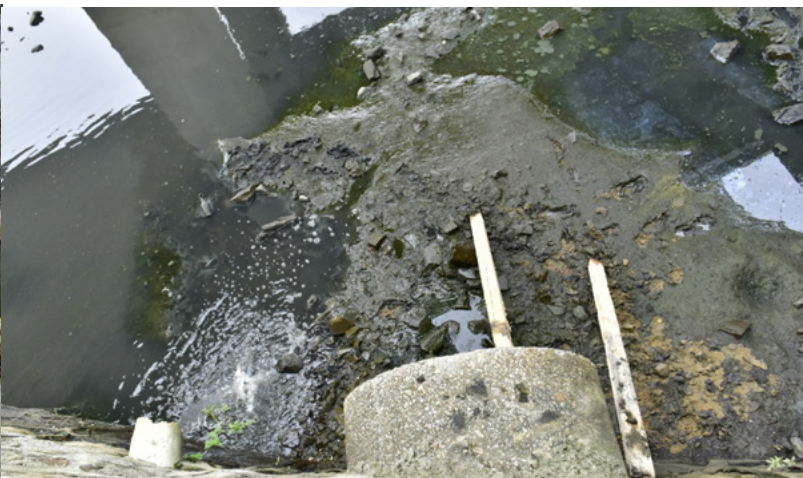
Dos salidas de alcantarillado (una grande y otra pequeña) provenientes de Zhuhai United Laboratories desembocan directamente en el río Nanpai
