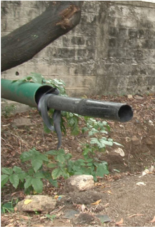
Tubo de desagüe en la pared de la fábrica de antibióticos de Orchid Pharma en Alathur, cerca de Chennai. Orchid asegura que esta fábrica utiliza una tecnología de gestión de residuos libre de vertidos.
